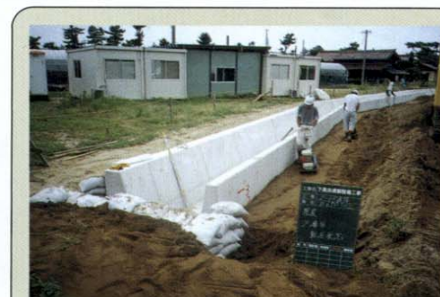
狭い所もしっかりとまわりの土を締め固めます。
