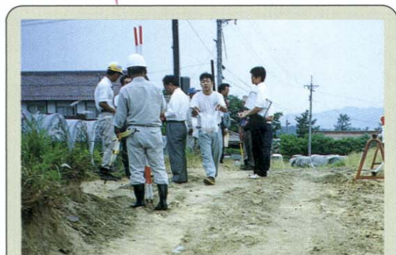
工事を始める前に、地元の方々に工事の説明を行います。工事への要望があれば検討し、返事をします。
