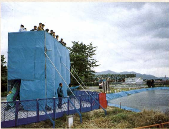
▲仮設展望台から新内藤川水門工事の様子を見学
