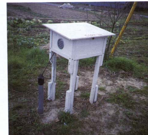
地下水観測所
