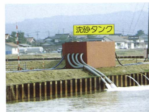
汲み上げた水は沈砂タンク及び沈砂池を通して、きれいな水を新内藤川に流しています。
