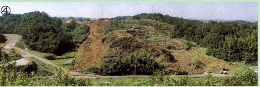
工事着手前の山の状況
