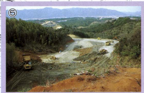
開削部の掘削土をB谷へ運搬するための工事用道路を設置する工事で、大型機械により盛土工事を行っています。放水路完成後は市道として利用される予定です。
