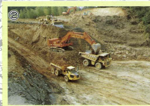
放水路開削部右岸の管理用道路部分と、掘削土を運搬するための工事用道路部分を掘削しており、超大型機械による掘削、積込、運搬作業が続けられています。
