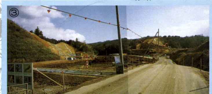
残土処理場設置に伴い、工事区域に降った雨が一度に流れ出るのを防ぐための防災調整池を設置する工事で、道路沿いの山の掘削作業を実施中です。
