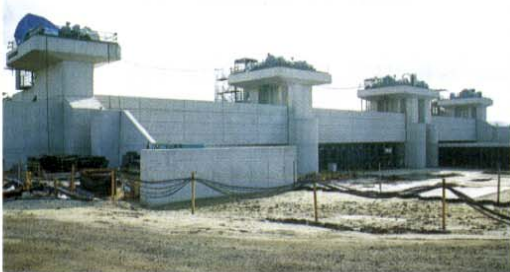
現在、ゲートを取り付けています。
