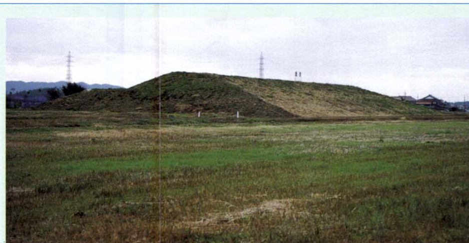
実際の堤防の大きさを長さ約80mの試験盛土を、境島地区、神門地区、芦渡地区の3箇所に設置しました。(写真は神門地区に設置した試験盛土)
