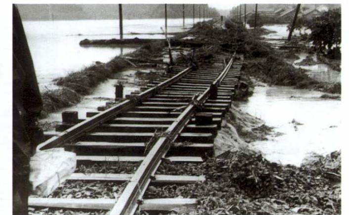
昭和39年7月 出雲市知井宮町地内 山陰線寸断
