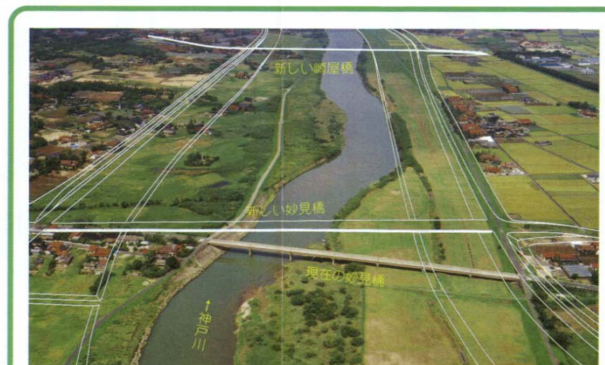
新しい妙見橋は下流から3番目の橋になります。
