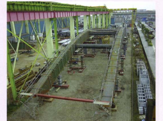
工場での仮組立
