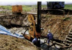
拡幅部中流付近で、堤防を造ることにより周辺の地盤が沈下しないようするための軟弱地盤対策を行っています。
