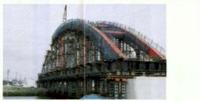
古志橋のシンボルとなる中央のアーチ状の橋桁、左岸側の橋台1基、橋脚1基、ボックスカルバート1基を施工しています。また、右岸側の橋桁を工場で製作しています。
