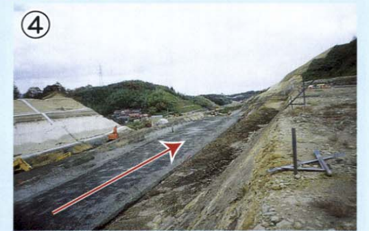
④ 右岸10K800付近
