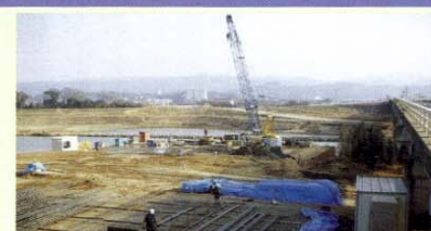
橋脚2基と右岸側の軟弱地盤対策工事に着手しました。
