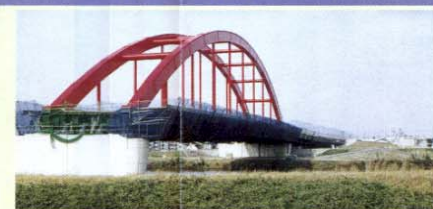
古志橋のシンボルとなる中央のアーチ状の橋桁、右岸側の橋桁、左岸側の橋台、橋脚、ボックスカルバートが完成し、橋中央から右岸側橋桁への床版工事、右岸側取付道路工事、左岸側の橋桁、取付道路、堤脚水路工事に着手しました。
