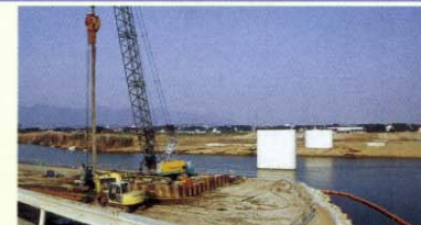
橋台1基、橋脚4基の施工に着手するとともに、右岸側の軟弱地盤対策工事にも着手しました。
