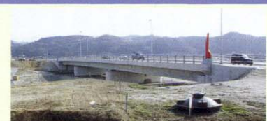
平成11年12月3日に開通式を行いました。また、馬木農道橋への取付道路工事に着手しました。
