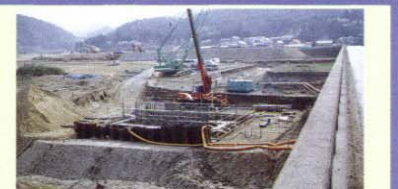
橋脚2基の工事に着手しました。
