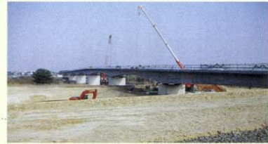
橋桁、左岸側の取付道路工事が完了しました。
