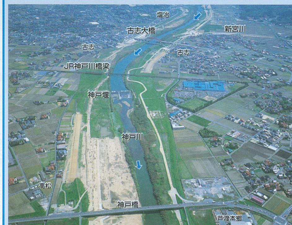
神戸橋・神戸堰・古志大橋付近
