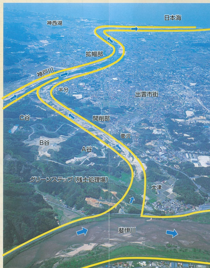
斐伊川放水路全体を望む
