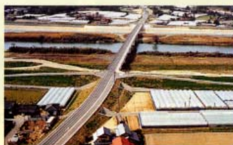
【斐伊川放水路崎屋橋取付工事】
