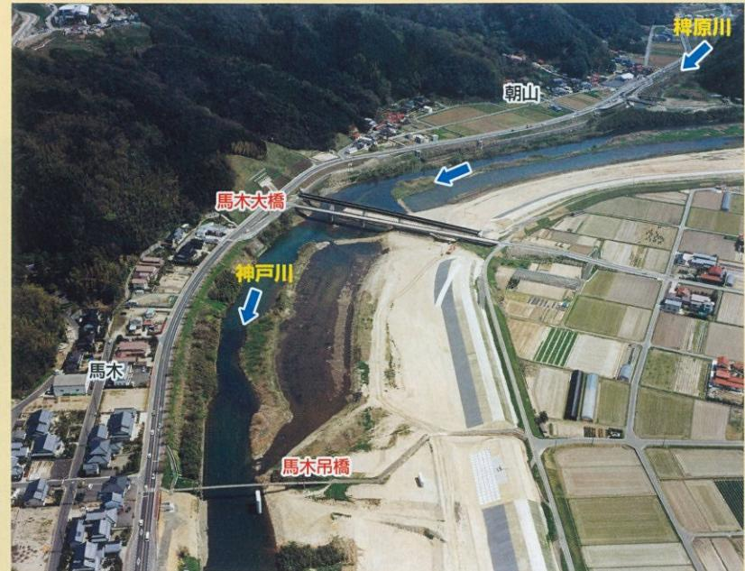
馬木大橋は、橋桁の架設が完成しました。現在、床版工と左岸取付道路を施工中で、今秋供用開始の予定です。
