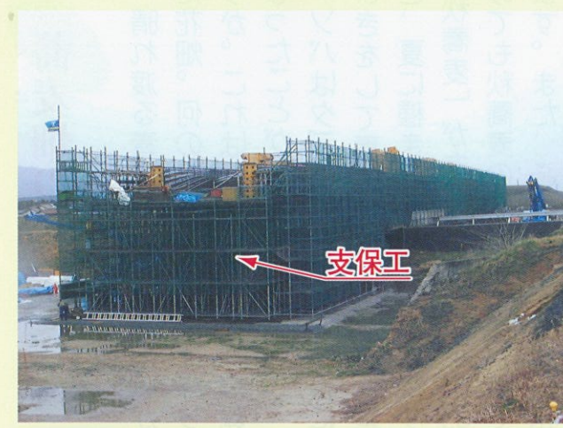
▲妙見橋架設状況
