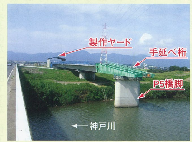
▲境橋架設状況(H15.8月)
