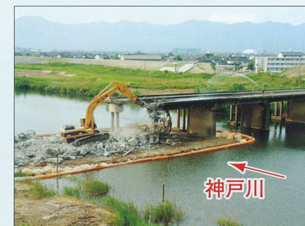
先人たちの技により造られた橋桁をコンクリート圧砕機により解体しました。
