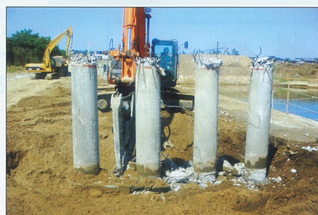
43年間、東西の交通を支え続けたコンクリート杭（直径50cm）の橋脚を解体。
