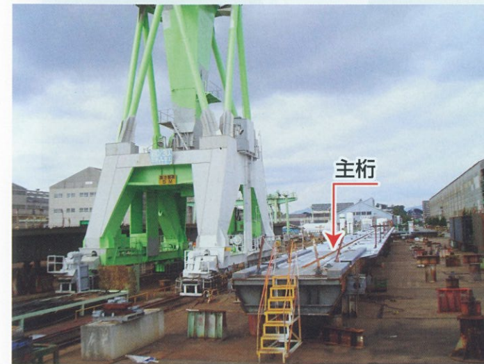
【工場での仮組立】 主桁全長(175m)の半分の長さ(87.5m)を工場を組み立てた状況
