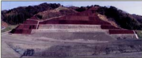
〈斐伊川放水路開削部下流掘削その2工事〉
