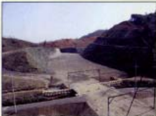
〈斐伊川放水路大津掘削工事〉
