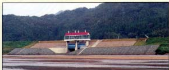
〈斐伊川出西護岸工事〉
