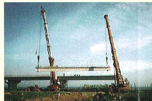
トラッククレーンによる主桁架設状況
