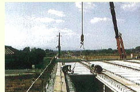
トラッククレーンによるPC板の敷設状況
