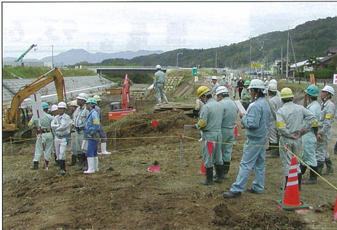
▲安全点検の様子（稗原川改修現場にて）
