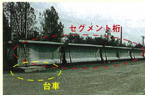
セグメント桁 (大井谷橋は1径間当たり3本です)
