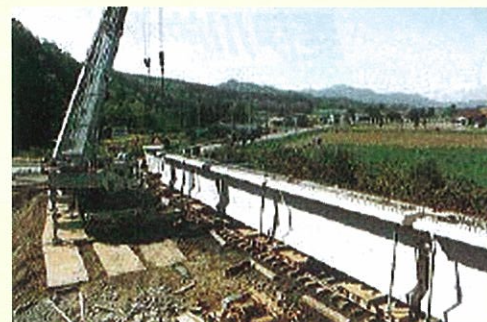
主セグメント桁組立状況
