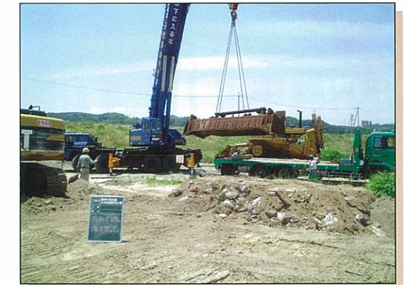
ブレード(排土板)の取付
