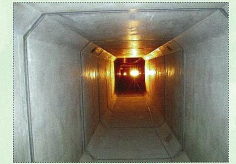
新しいトンネルは、高さが1.8m、幅が1.5mのボックスカルバートという形で付け替えます。
