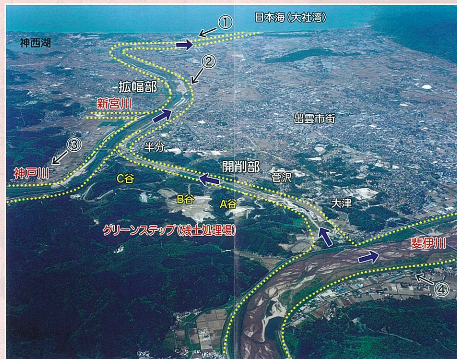
写真:平成17年4月撮影
