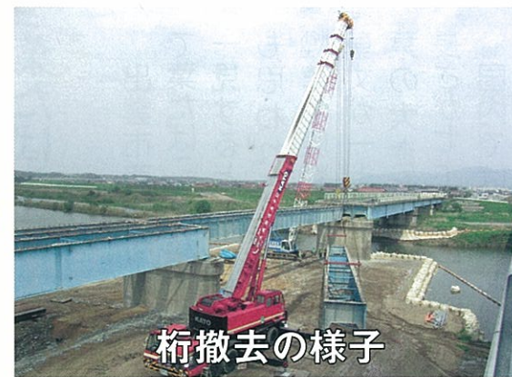
②クレーンで橋桁の撤去を行い、切断した後トラックで運び出します。
