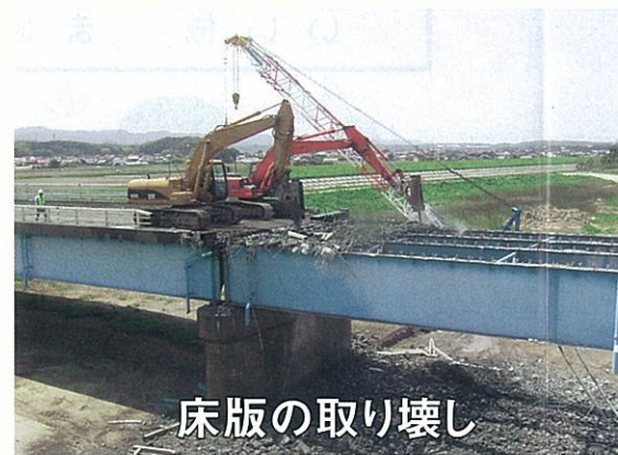
①床版を大型ブレイカーで取り壊します。
