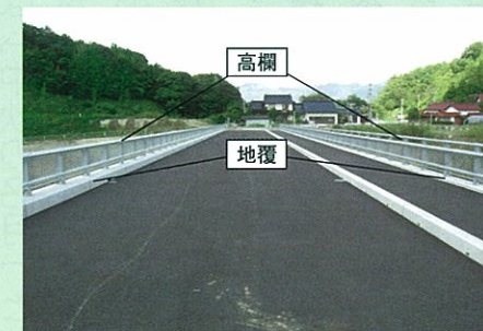
<地覆・高欄設置>
