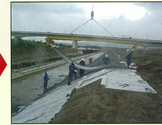
クレーンでブロックマットを設置します。
