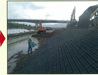
バックホウで土を被せます。
