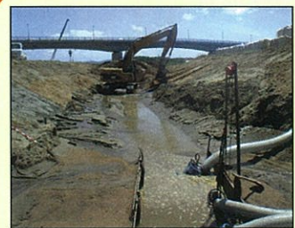
バックホウで掘削します。
