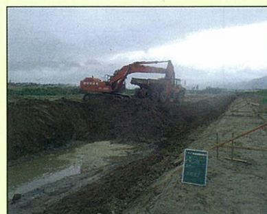
バックホウで掘削します。
