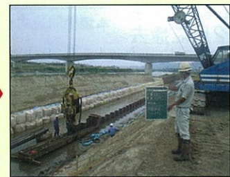
鋼矢板L=7.5mを打設します。
