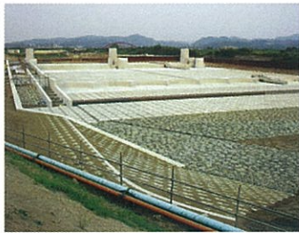
▲右岸側施工完了(平成17年6月)
