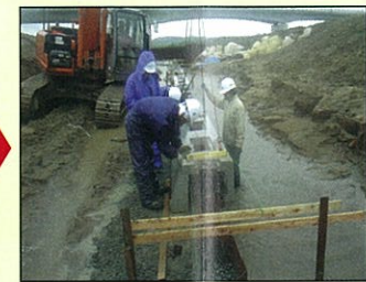
笠コンクリートを設置します。
