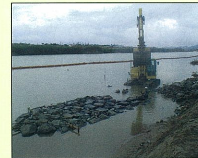
捨石を投入し、表面を均します。
