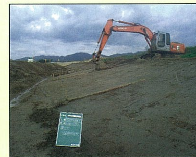
バックホウで土を被せます。
