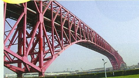
阪神高速の港大橋
