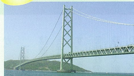
本州四国連絡橋の明石海峡大橋
