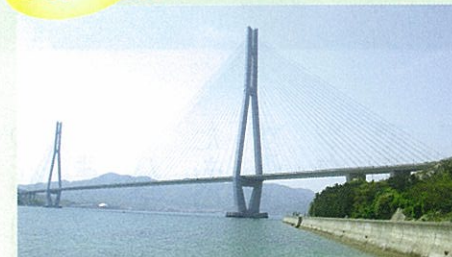
広島県と愛媛県を結ぶ多々羅大橋
