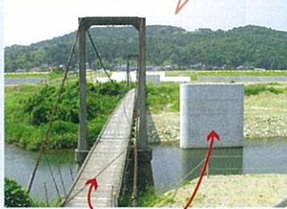
旧吊橋と新吊橋の橋台
