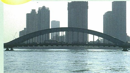
東京都隅田川にかかる永代橋
