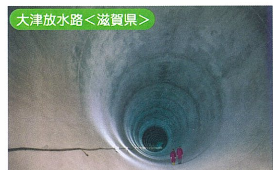
直径10m以上、全長約4.7kmのトンネル水路。2003(平成15)年通水
