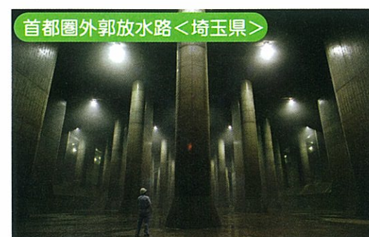
直径10m、全長約6.3km、地下50mのトンネル水路。2001(平成13)年通水 (写真は調圧水槽)
