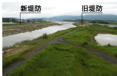
旧堤防撤去前の様子
