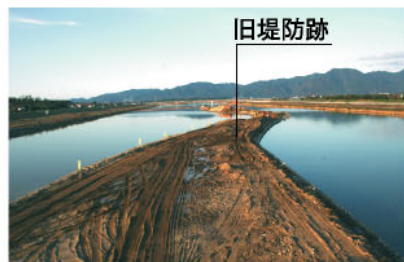
撤去中の様子
