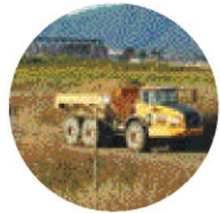
土砂を運搬するダンプ
