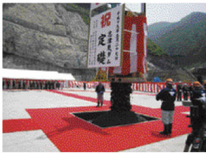
バケット開放による礎石の埋納
