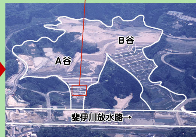
現在の状況（平成19年5月撮影）
