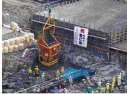
バケットからコンクリートを放出
