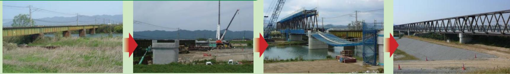
平成17年3月 工事着手前の様子    平成18年3月 下部工(橋脚)完成    平成18年4月 トラス橋架設開始    平成18年12月トラス橋完成！
