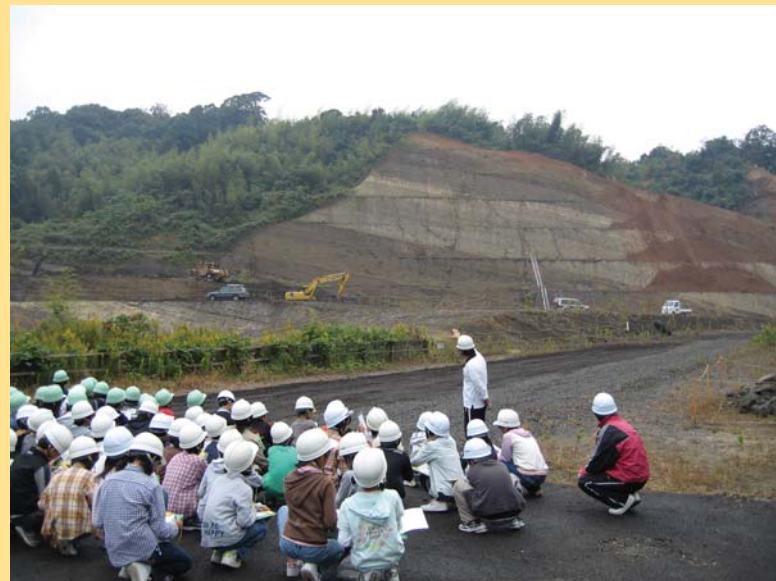
11月1日(木)斐伊川放水路開削部の工事現場で、地層の見学をしました。
