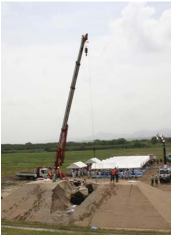
建設機材を使った堤防の 応急締切工
