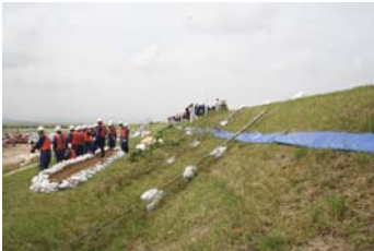
代表的水防工法「木流し工・竹流し工」(写真左)と「出雲結工」(写真中)
