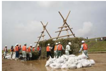
代表的水防工法「木流し工・竹流し工」(写真左)と「出雲結工」(写真中)
