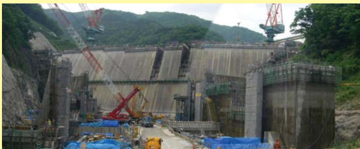
志津見ダム工事の様子
