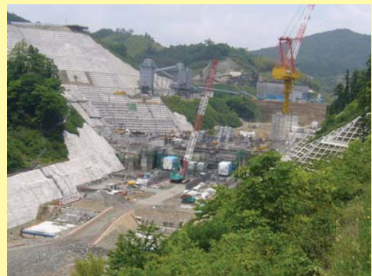
尾原ダム工事の様子
