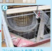
コンクリートを流し込み ながら鋼管を抜く
