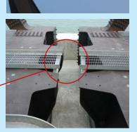
トラス上下部。伸び縮みし、 振動しても壊れない構造。
