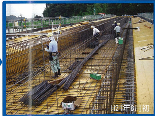
H21年8月初 組み上がった支保の上で型枠設置、配筋、作業を行います。
