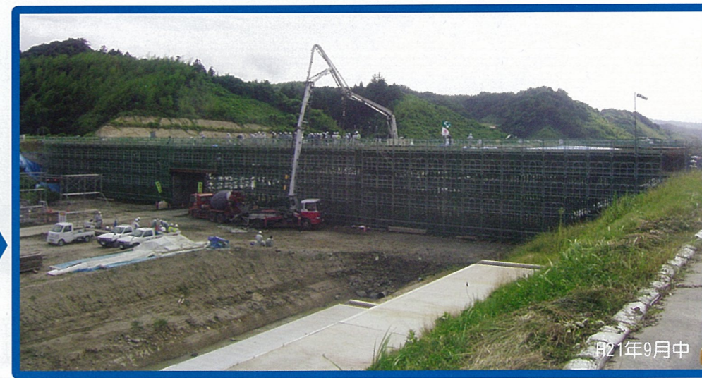
H21年9月中 配筋完了後コンクリート打設を行います。
