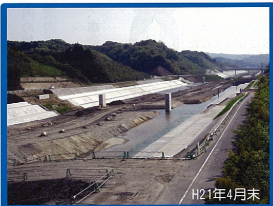
H21年4月末 上部工事施工前の状況です。下部工(橋の土台)が見えています。
