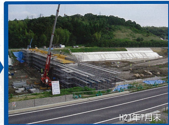
H21年7月末 下からクレーンなどを用いて支保と呼ばれる支えを組み立てて橋桁と同じ高さにします。
