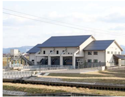
新内藤川排水機場
