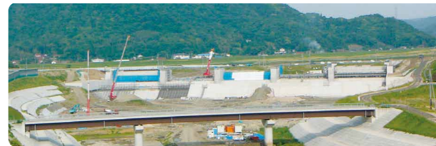
斐伊川放水路の下流から撮影(H23.5.31)
