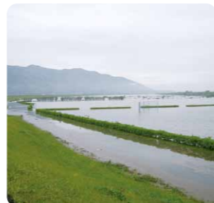
写真/河川敷公園 斐伊川の高水敷にある河川敷公園などが冠水しました。
