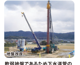
軟弱地盤であるため下水道管の沈下を防ぐために基礎となる杭を設置します。
