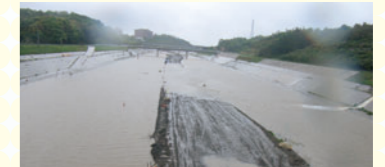
浸水した現場
