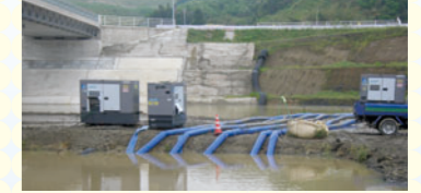
ポンプで水を切り回す状況
