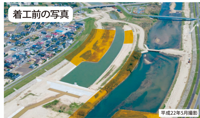
着工前の写真 平成22年5月撮影 H22年度の工事により黄色部の掘削・護岸・導流堤築堤工事を行いました
