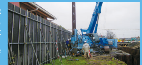
防護壁を設置しての工事
