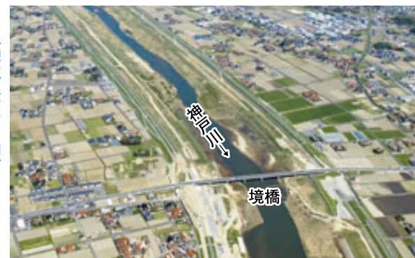
川幅が広がり、堤防を新たに整備しました。(一部は現在も施工中)
