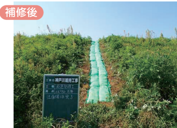
植生土のう設置
