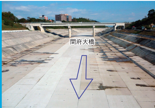
平常時(放水路開削部)
