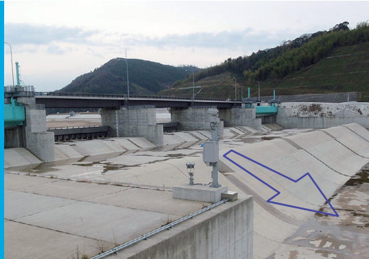
平常時(斐伊川放水路分流堰)
