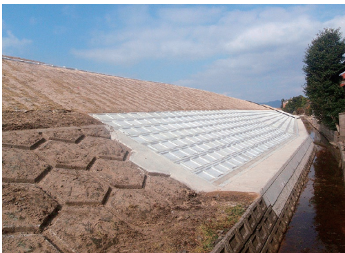
原鹿地区の堤防工事
