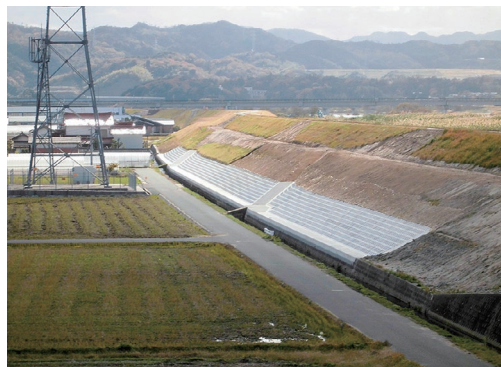
名島地区の堤防工事
