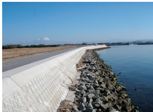
葭津地区の湖岸堤防整備
