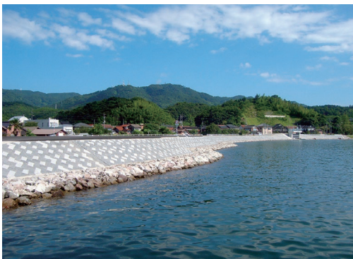
本庄地区の湖岸堤防整備
