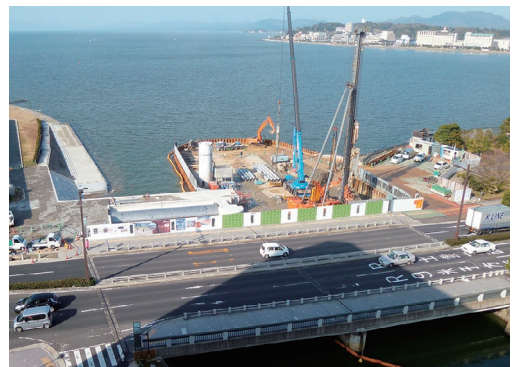
天神川水門の工事
