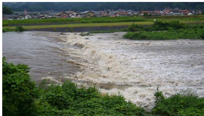
木次床止め工（雲南市木次町）
