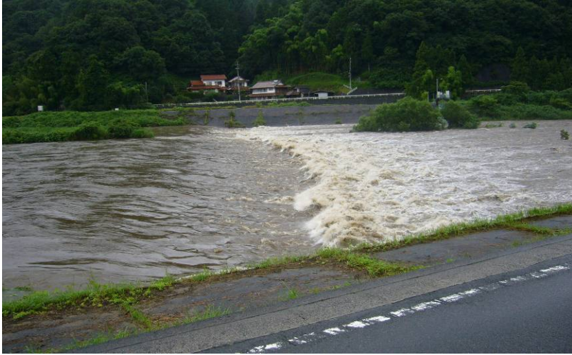
給下床止め工（雲南市三刀屋町）
