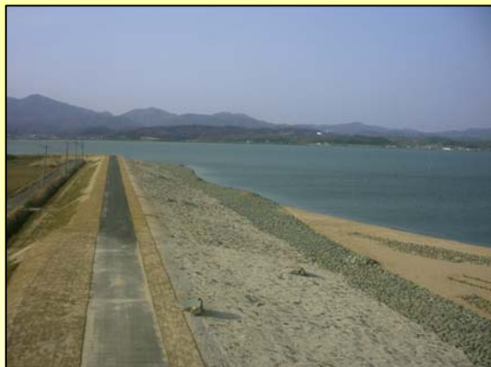
施工直後 (平成14年)
