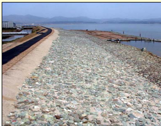
施工直後 (平成14年)
