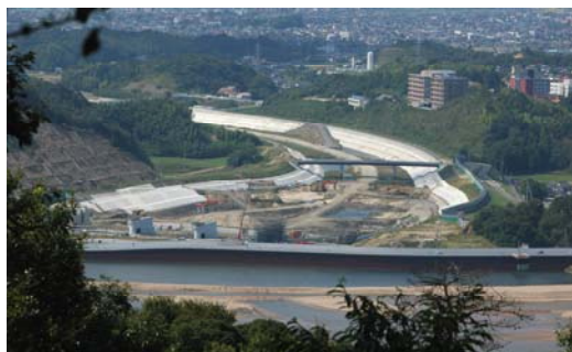
眼下に斐伊川、正面には整備中の斐伊川放水路
